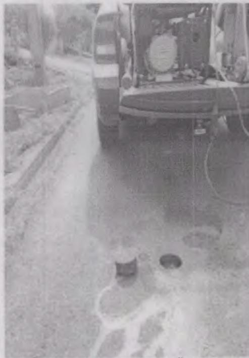
FIGURA 02: EXTRAÇÃO DE TESTEMUNHO
