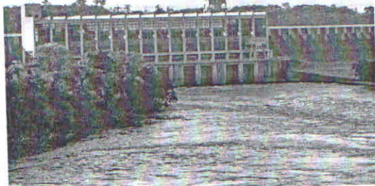
Em Salto Grande, os auditores verificaram a documentação, acompanharam os procedimentos operacionais e as rotinas
