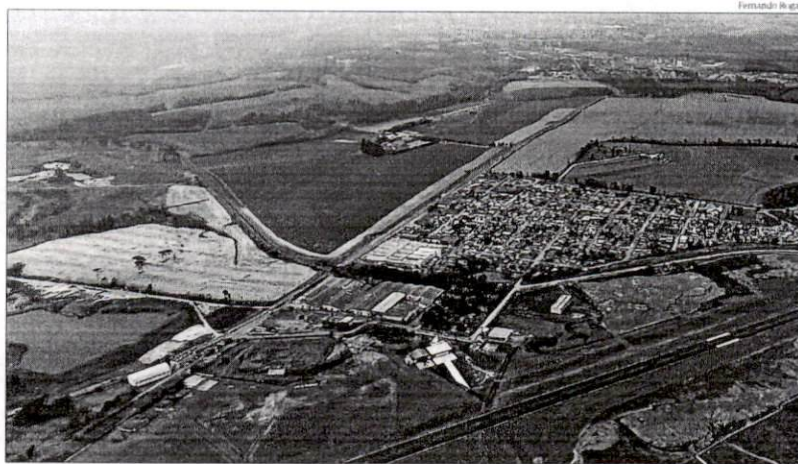
Trecho a ser duplicado é compreendido entre os trevos da BR-376 e PR-438, passando pelo Aeroporto
