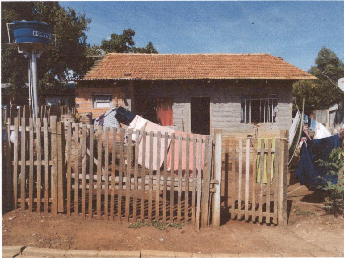
CASA SITUADA NA VILA BRASIL (ÁREA DE RISCO)
