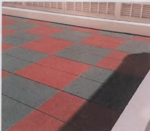
Placas pigmentada nas cores terracota e verde, fabricada de borracha reciclada de pneu inservível, fixada no local com resina de poliuretano, na medida 1 m x 1 m x 43 mm espessura, incluso instalação e materiais.
