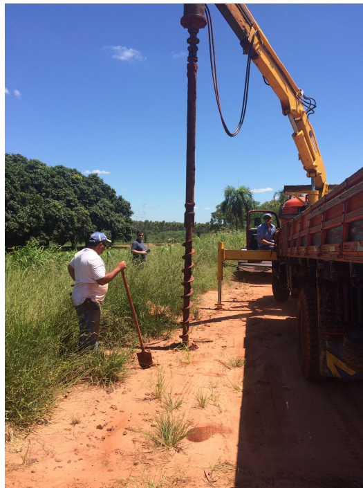
Figura 1 - Escavação com trado mecânico
