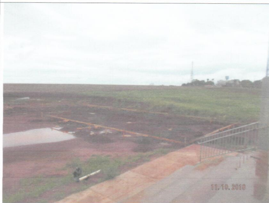
Foto 02: Canteiro de obras no mês de Outubro, ainda sem condições de trabalho.
