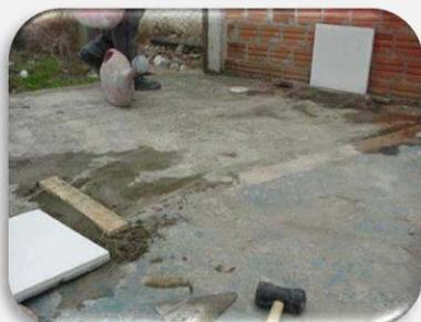
3. Após a fixação das taliscas esticar duas linhas (no sentido do alinhamento) separadas uma da outra pela largura da placa, para servir de mestra, tanto do nivelamento quanto do alinhamento, no momento do assentamento.
