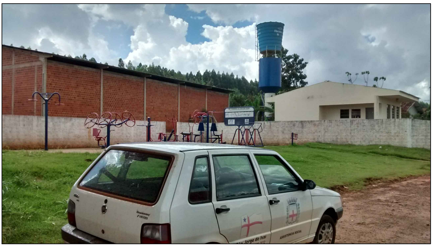
RESERVATÓRIO ELEVADO A SER DESATIVADO
