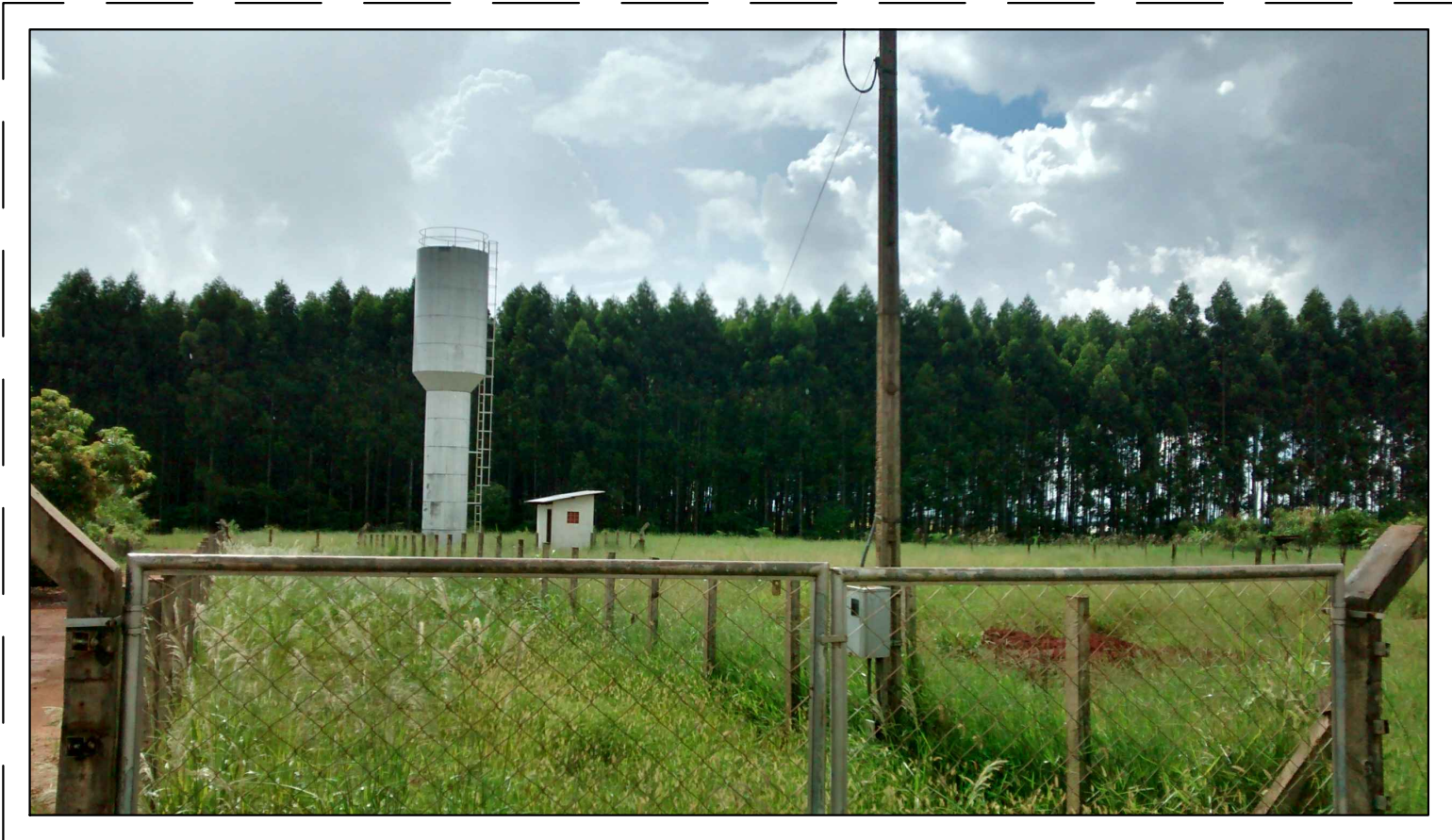
RESERVATÓRIO ELEVADO A SER UTILIZADO PARA ABASTECIMENTO DA HORTICULTURA
