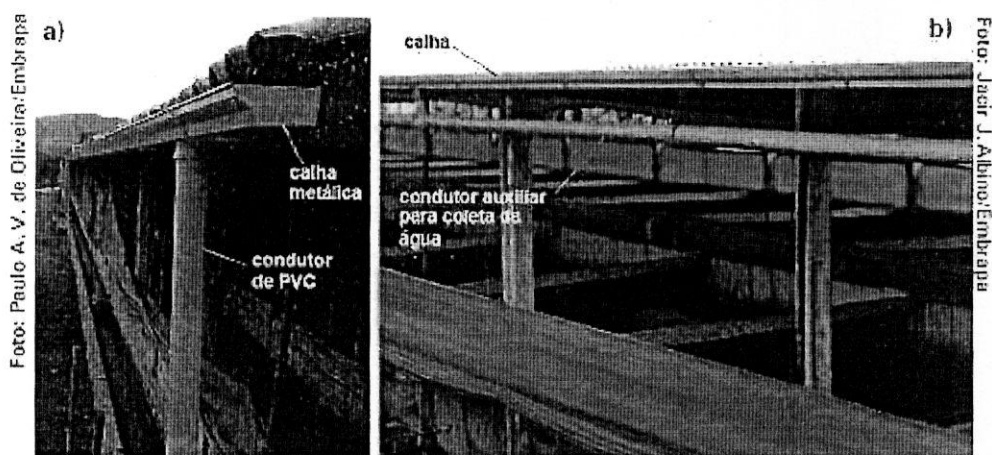
Figura 26 – Modelo de Calhas Com Condutores
