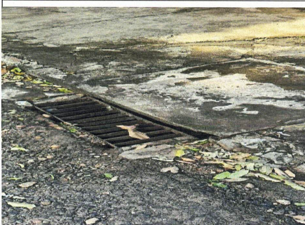
Bocas de Lobo existentes no local.
