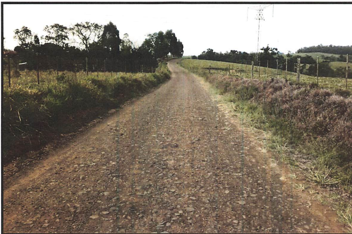
Foto 02: Início do Trecho
