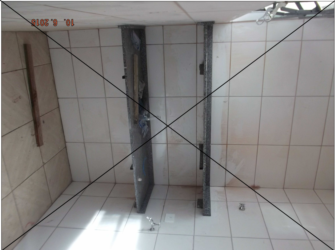
PRATELEIRAS EM GRANITO - foto de referência NÃO SERÁ ACEITO FIXAÇÃO / APOIO COM BARRAS DE METALON
