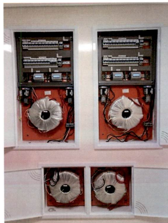
Imagem ilustrativa de quatro Sistemas IT Médico em centro de distribuição embutido SIT14000/DT-E e SIT14000/TE. →
