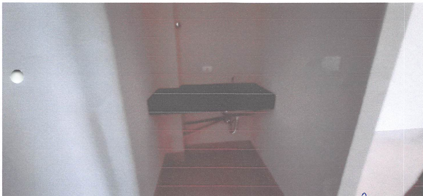
Foto n.º 06 VISTA DA COPA
